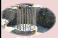
場所打ち コンクリート杭
