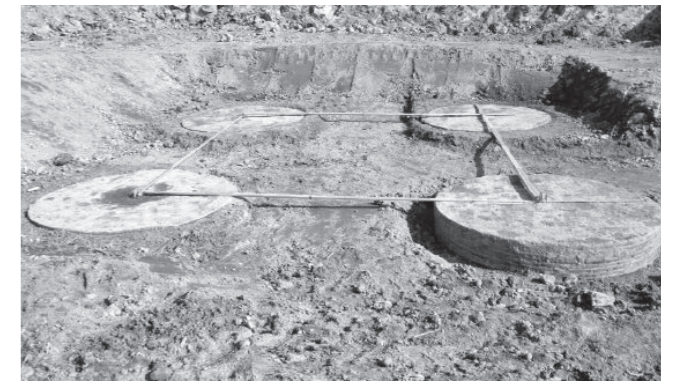
柱状地盤改良杭
