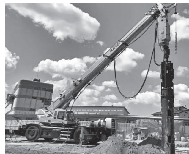
チャッキング工法による杭抜き工事の様子
