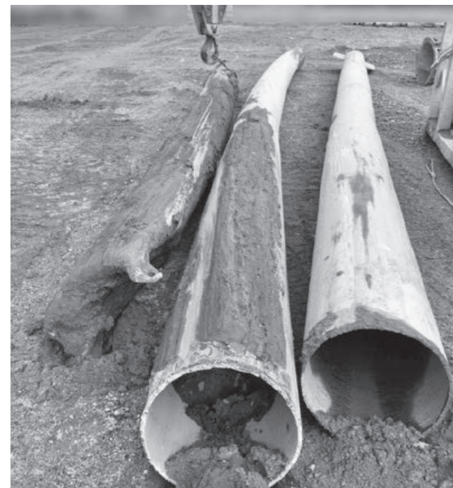
先端が潰れて変形、大きく湾曲した杭
