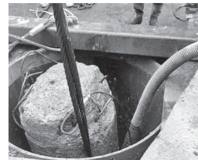
流動化処理土による埋め戻し
