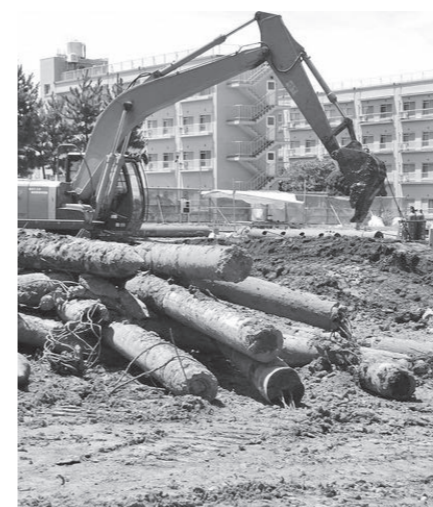
輪投げ工法による杭抜き
