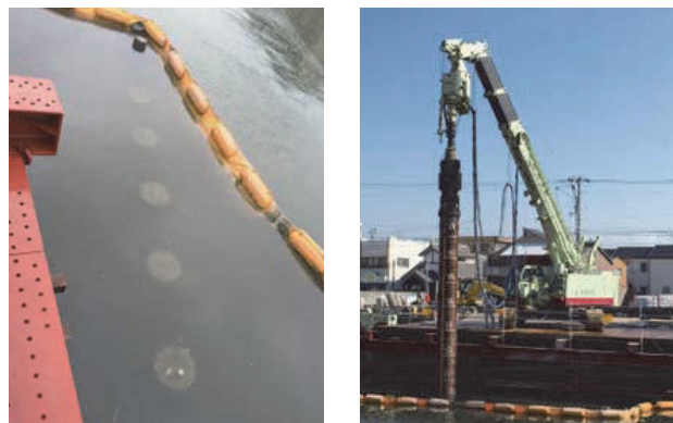
図-8 水中に杭頭がある際の引抜き
