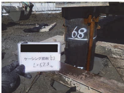
図-9 新設杭干渉部での引抜き (67m)
