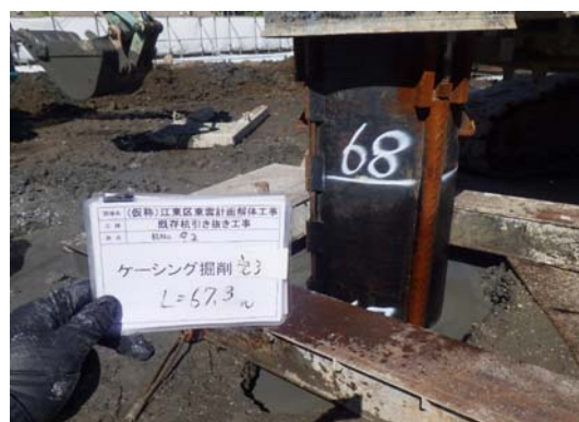
図 9 新設杭干渉部での PG 工法による引抜き施工例
