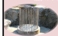
場所打ち コンクリート杭
